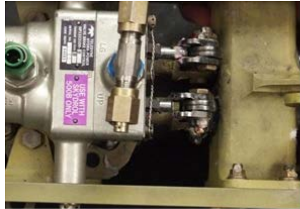
Figure 2 : Piston inférieur dont le ressort est brisé, car sa tige-poussoir n'est pas en contact avec la timonerie de commande.
