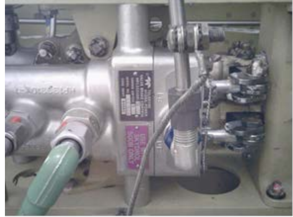
Figure 1 : BCV en état de service, dont les deux tiges-poussoirs sont en contact avec la timonerie de commande.
