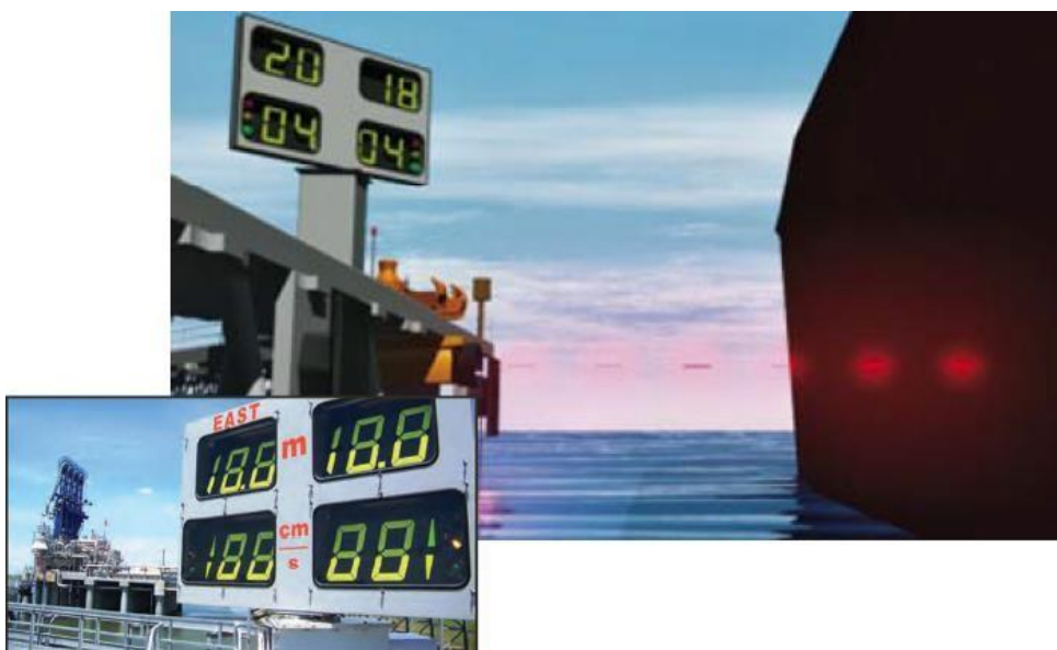
Figure 3.3.2-3 Image d'une planche d'amarrage de jetée. Référence : Présentation de Goldboro GNL au CET
