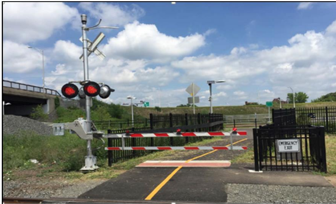
Figure d'appendice M-14 Exemple de barrière à jupe de passage à niveau et sortie d'urgence
