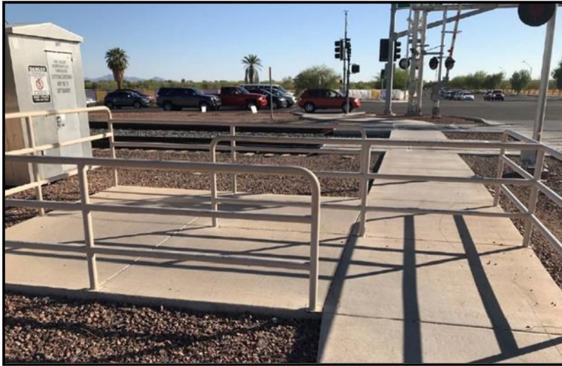
Figure 26-2 Exemple d'image d'une barrière disposée en chicane pour passage à niveau public
