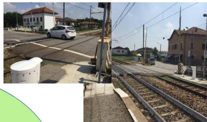
•Cressa •(NOVARA – DOMODOSSOLA, DTP Torino)
