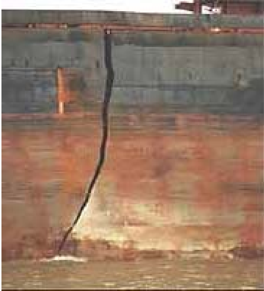
Fracture du côté tribord
