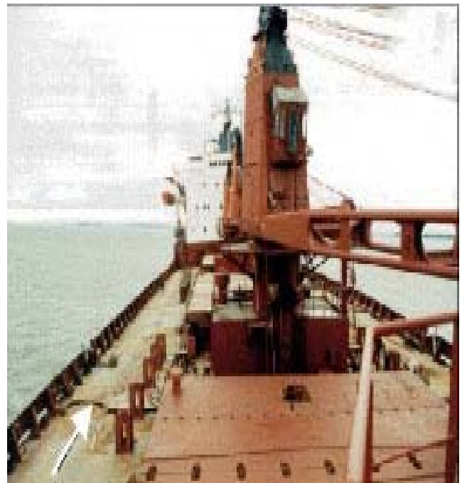
Fracture sur le pont principal (voir la flèche)
