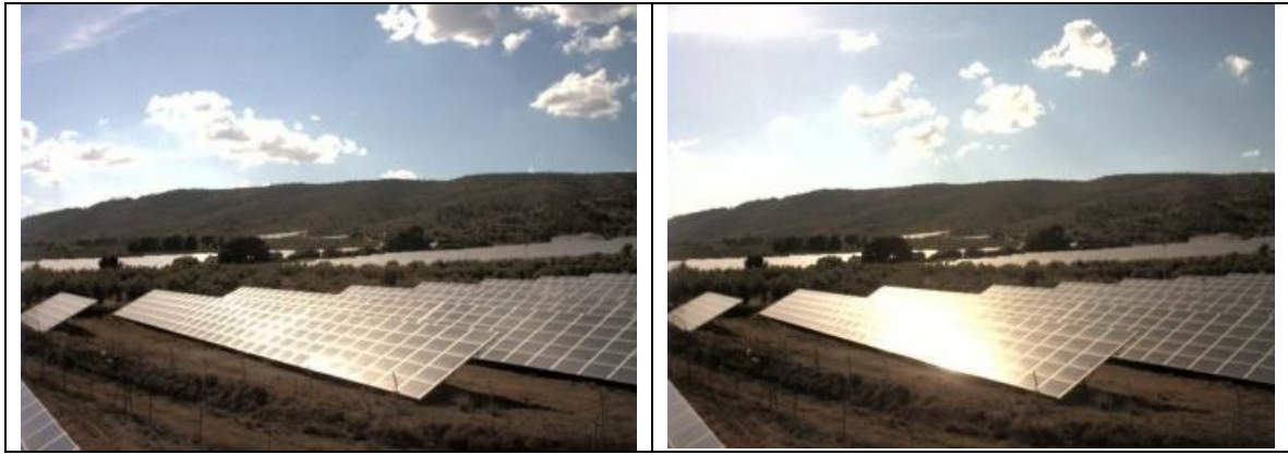
Figure 5. Réflexion par les panneaux solaires
