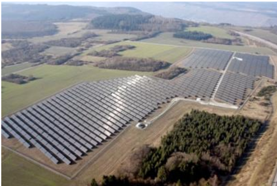
Figure 4. Parc solaire Mehringer Höhe I, en Allemagne - www.juwi.com
