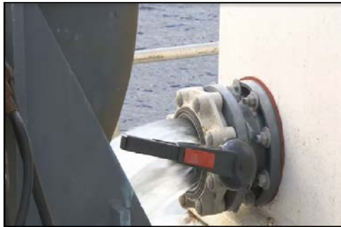
Figure 4.0 (g)(ii) : Vanne de décharge d'une citerne antiroulis à bord d'un bâtiment de pêche. (Source : FVSS – CCPP)
