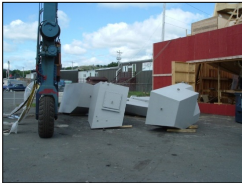
Figure 3.0 (f)(i) : Réservoirs de carburant spécialement conçus, pré revêtus et prêts à être installés. (Source : collection personnelle de J.G.)
